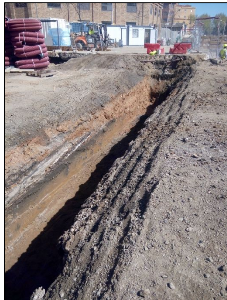
F16.- .- Rasa corresponent al traçat del clavegueram, en la zona de connexió amb el carrer del Treball.
