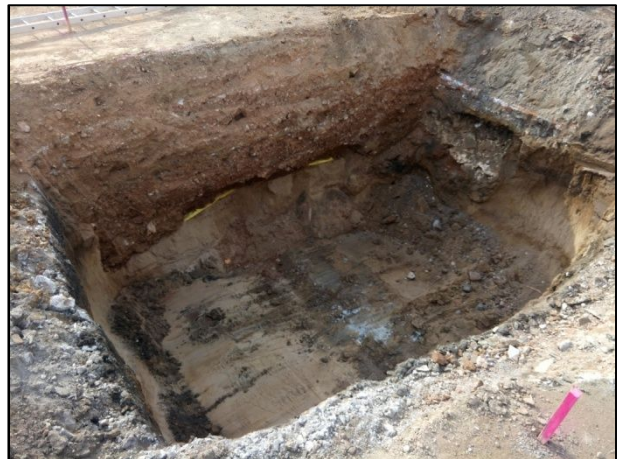
F12.- Vista general d'una de les fosses destinades a les arquetes corresponents al traçat de la RSU.
