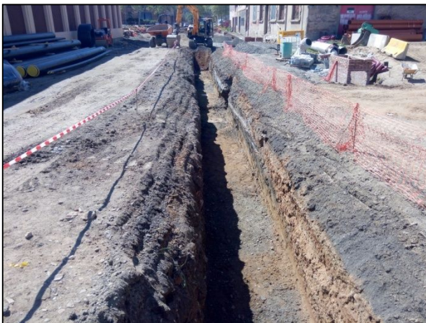
F15.- Vista general de la rasa corresponent al traçat del clavegueram.
