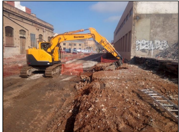
F4. Treballs de la màquina giratòria.
