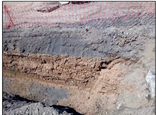
F20.- Detall de l'estratigrafia documentada; estrat heterogeni UE 01, l'estrat gris superior correspon a un estrat de grava dipositat per facilitar les tasques de treball de l'obra.
