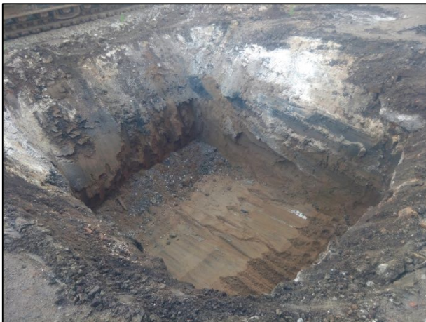
F11.- Vista general d'una de les fosses destinades a les arquetes corresponents al traçat de la RSU.
