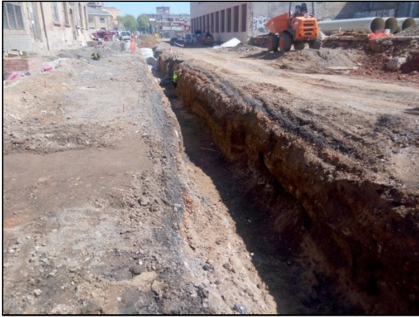
F17.- Vista general de la rasa corresponent al traçat del clavegueram.
