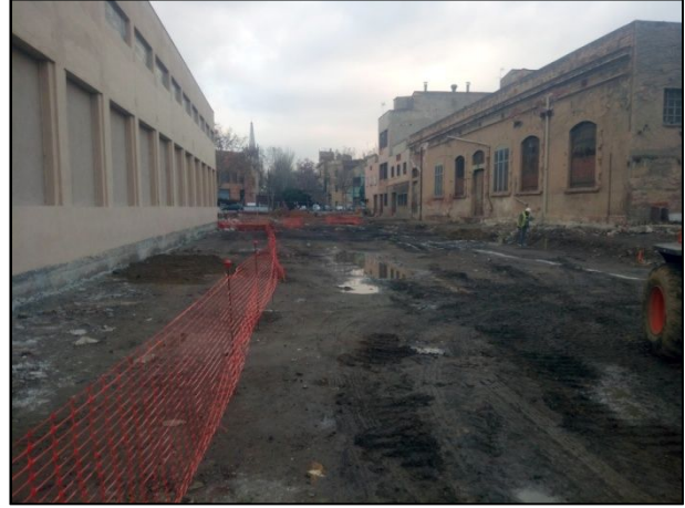
F2.- Vista general del carrer del Marroc, amb els rebaixos inicials realitzats.
