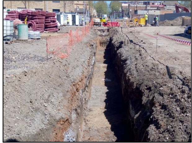
F18.- Vista general de la rasa corresponent al traçat del clavegueram.
