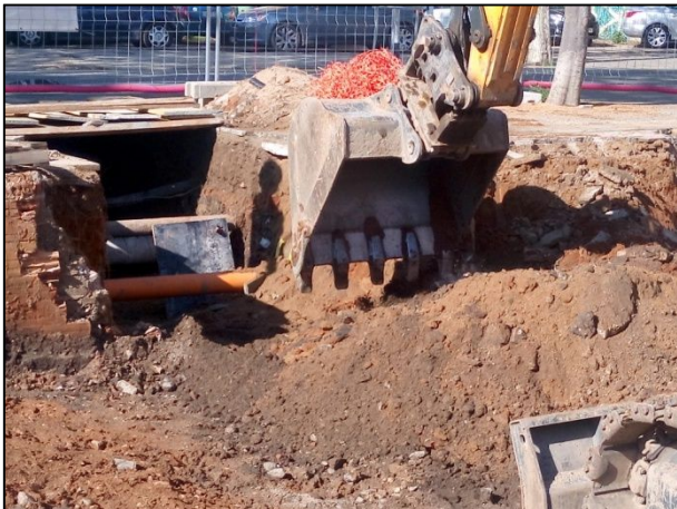
F7.- Tasques de localització dels serveis en la zona de connexió amb el carrer de la Selva de Mar.
