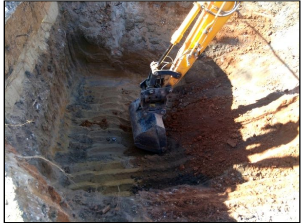
F6.- Treballs de la màquina giratòria.
