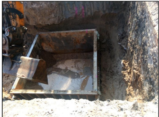
F8.- Detall de l'aflorament del nivell freàtic en l'estrat de sorres de platja UE 02.
