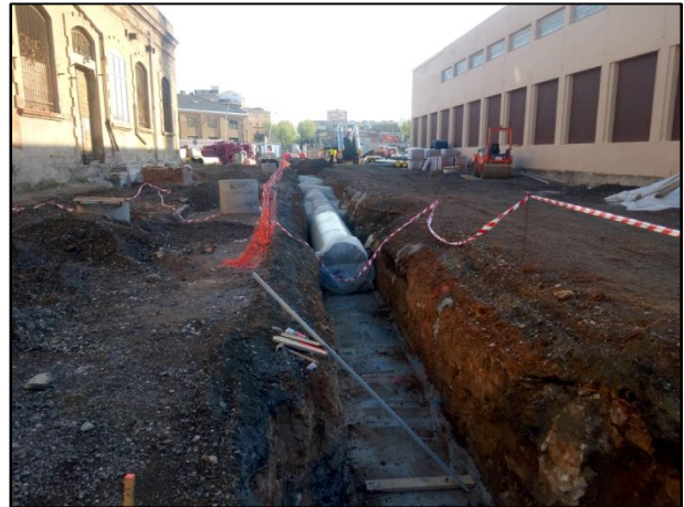
F24.- Vista general del tram d'obra amb el traçat de clavegueram ja col·locat.
